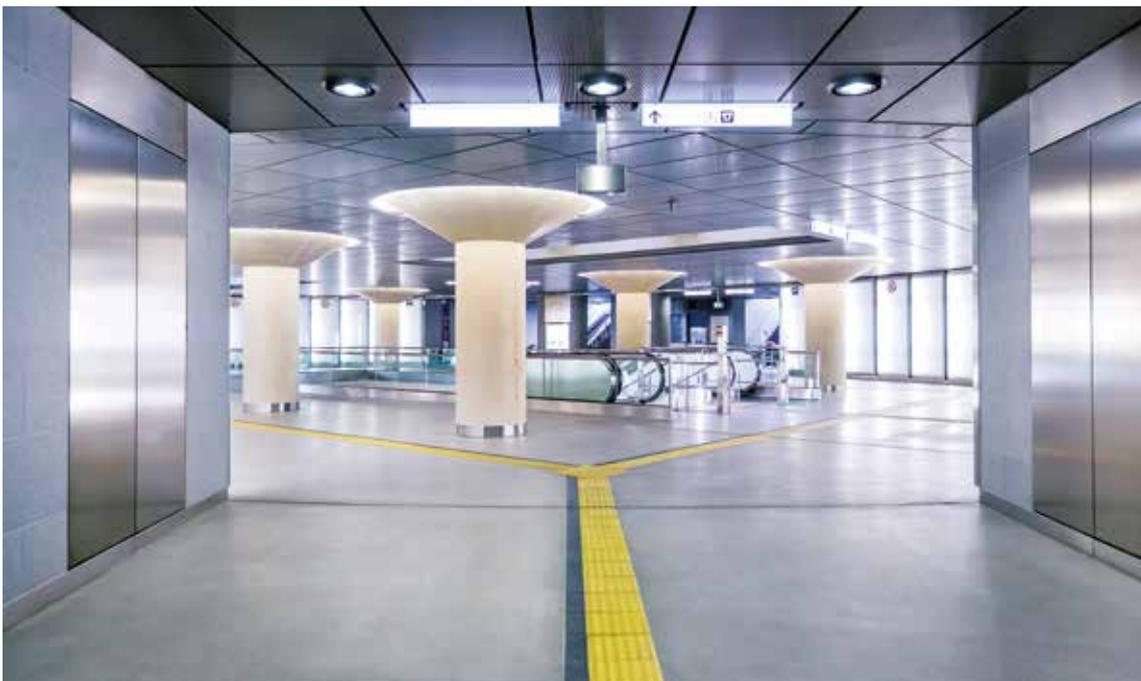
**Haltestelle Chlodwigplatz:** Steinerne „Pilze“ stützen die Decken der Verteilerebenen, durch große Oberlichter fällt Tageslicht in die Eingangsbereiche.
